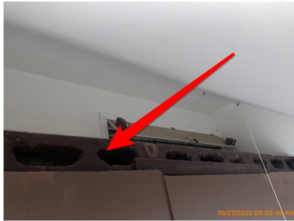
Concrete ceiling edge
