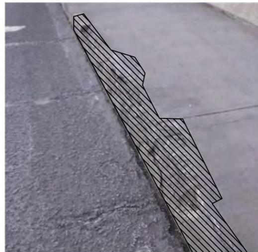
**TYPICAL SIDEWALK CURB SPALL**
