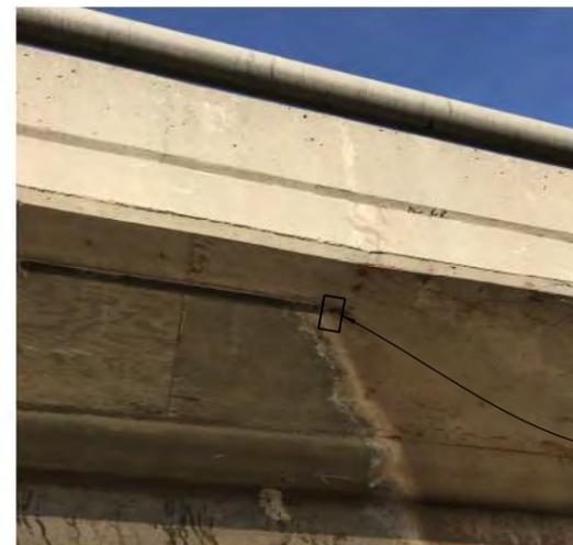
**ABUTMENT 12 - DEFICIENT DRIP EDGE**
