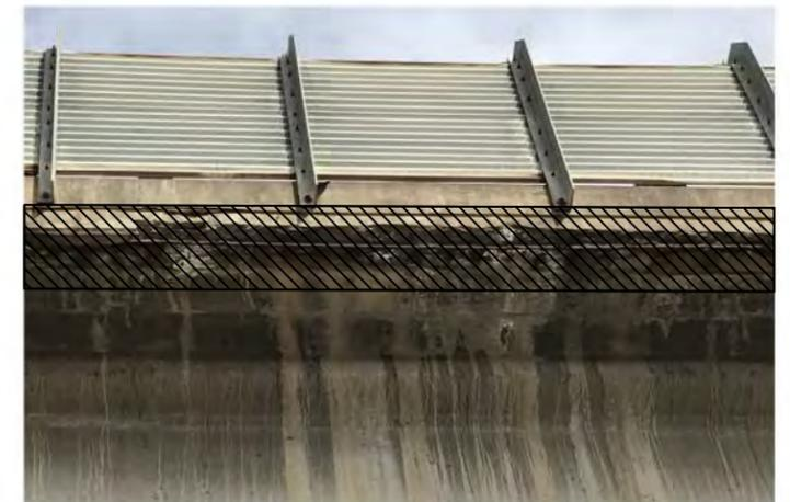
**TYPICAL DECK SOFFIT SPALL**
