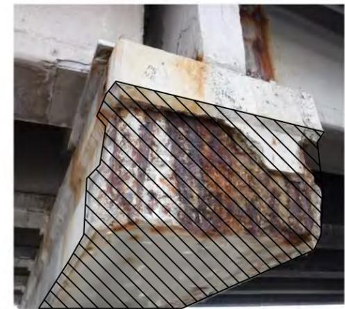
**PIER 5 - NORTH END OF CAP SPALL**
