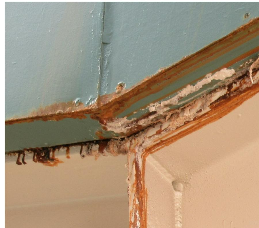
**A4** **TYPICAL RUST AT INTERSECTIONS OF STEEL**
