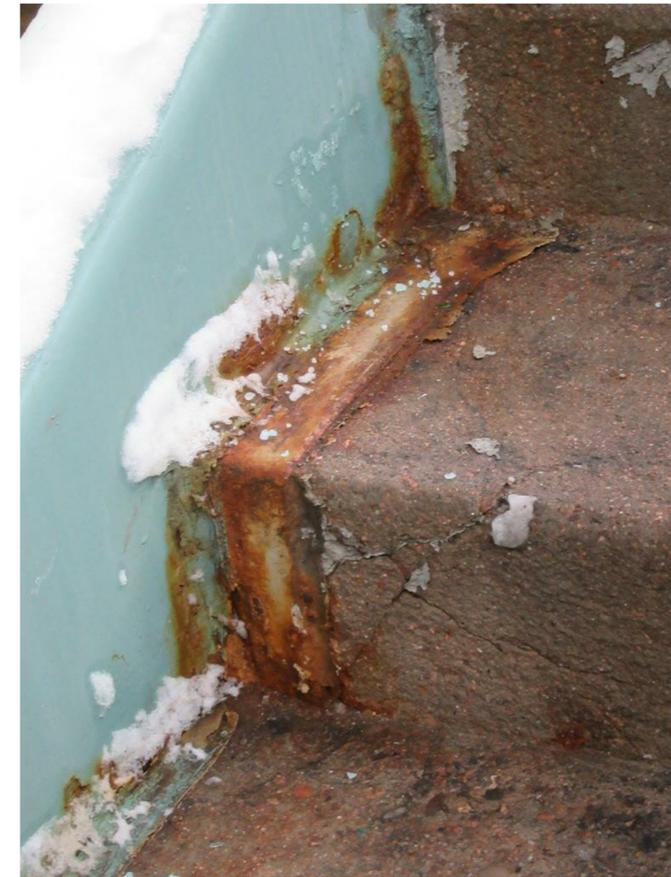
**A2** **TYPICAL RUST AT TREADS/RISERS**
